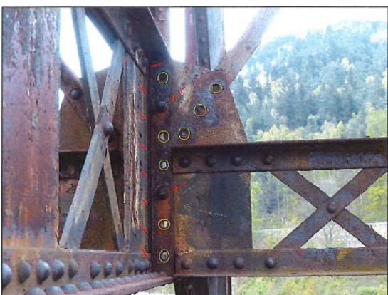
5. K 03 příhrada č. 14 na konci svislý styčnickový plech nadmostovkového ztužení v místě uchycení ke stěně příčného horního ztužení – Chybějící krční úhelník vlevo, 5 nýtů a 11 hlav nýtů → styčnicku uchycen pouze 2 šrouby (šrouby nedotažené a namožené)!
