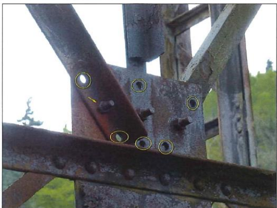
4. K 03 příhrada č. 14 uprostřed svislý styčnickový plech nadmostovkového ztužení v místě uchycení úhelníků ztužení – chybí 5 nýtů a 1 hlava nýtu → každý úhelník uchycený jen 1 šroubem.
