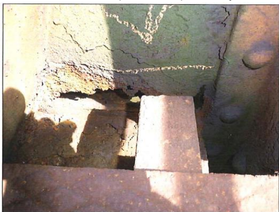
3. K 02 svislice č. 7 vpravo – korozně oslabená (vyrezlá) svislá stěna koutové výztuhy v ploše 250x60 mm.
